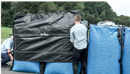
Überziehen der Schutzhaube, um den Zweier-Verbund herzustellen
