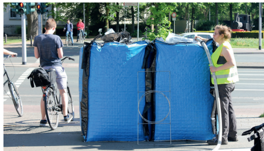
Füllzeit mit Wasser: B-Schlauch ca. 1 Minute, C-Schlauch ca. 2,5 Minuten
